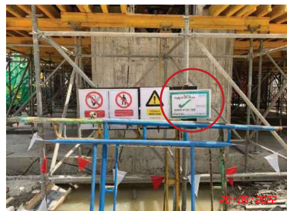
รูปที่ 2-35 น้จรั้น และการตรวจสอบน้จรั้น
