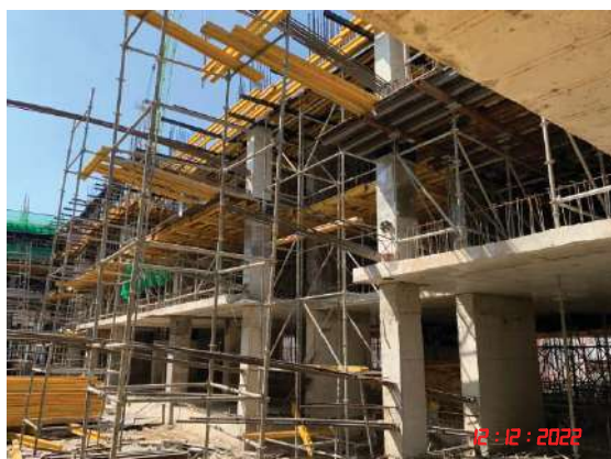
รูปที่ 2-35 น้จรั้น และการตรวจสอบน้จรั้น
